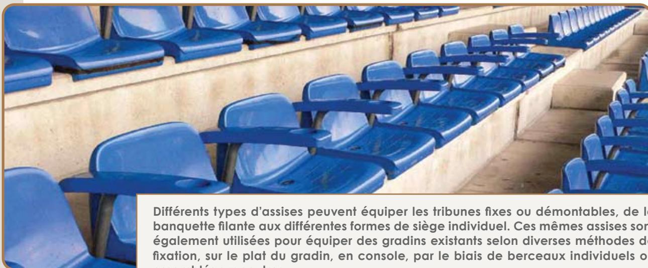
Différents types d'assises peuvent équiper les tribunes fixes ou démontables, de la banquette filante aux différentes formes de siège individuel. Ces mêmes assises sont également utilisées pour équiper des gradins existants selon diverses méthodes de fixation, sur le plat du gradin, en console, par le biais de berceaux individuels ou assemblés sur poutres.
