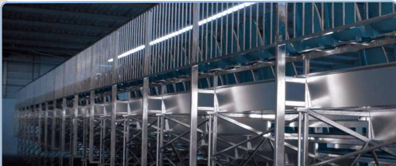
Les tribunes démontables peuvent être implantées dans les salles à usage multiple ou sportif ainsi qu'en extérieur. En conséquence, elles relèvent des recueils "TYPE L", "TYPE X" ou "TYPE PA" des règlements des E.R.P\*.
