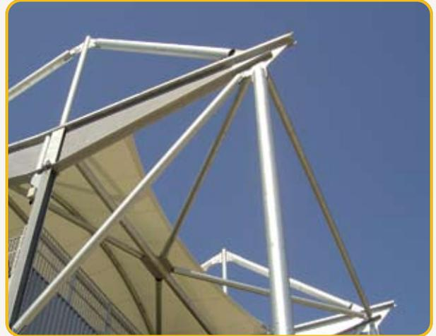
Outre la charpente métallique galvanisée, deux types de matériaux sont proposés pour la couverture, celle-ci pouvant être réalisée en bac acier galvanisé prélaqué ou en toile de polyester enduit PVC. Dans cette dernière formule, la couverture est constituée de lés découpés en forme et posés en double courbure sur les ossatures, le grammage du tissu étant choisi en fonction des efforts climatiques de la région.
